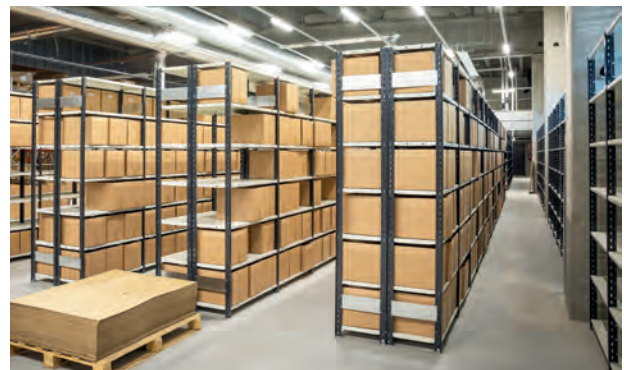
Lähetys- ja vastaanottoalueiden yläpuolisille parville asennettiin noin 10 000 hyllymetriä pientavarahyllyä.
