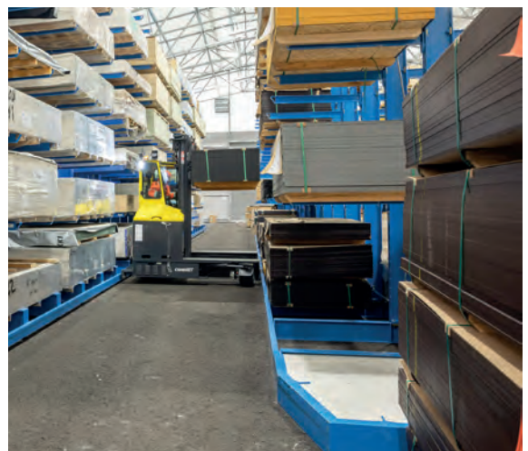
Ulokehyllyjen jalkapalkkeihin asennettiin ohjauskiskot ja hyllyjen pätyihin ohjauskaaret.
